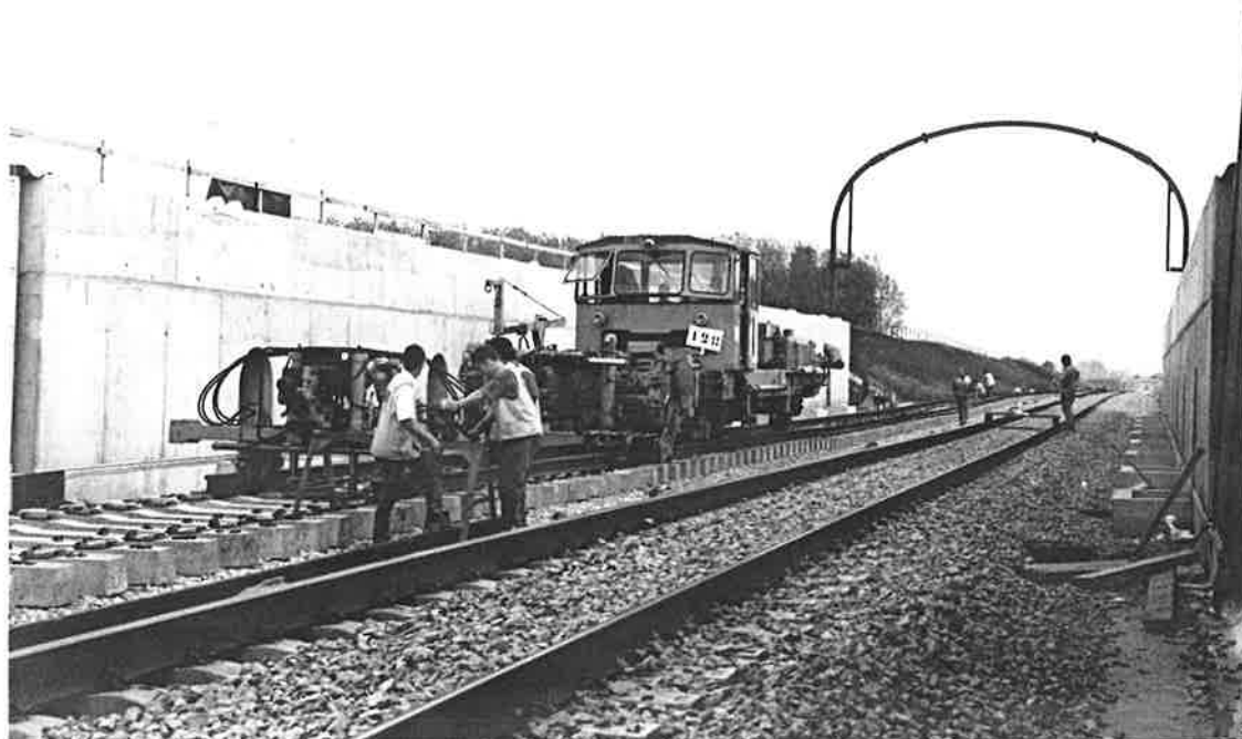
Pose de voie de la LGV à l'entrée du viaduc d'Antoing (13 octobre 1995) - photo Guy Bridoux
