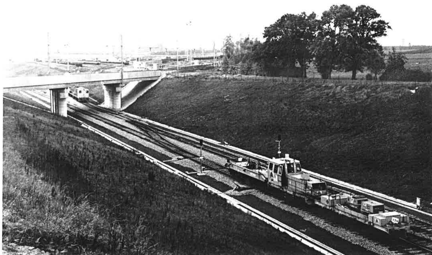
La LGV avec à l'arrière plan la base de travaux de Saint-Druon (13 octobre 1995) - photo Guy Bridoux
